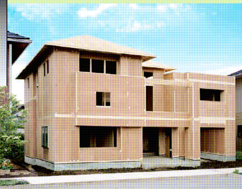
工場生産された木質パネル(壁・床・屋根)を施工現場で組立る木質パネル接着工法
