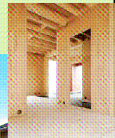
構造体組立て直後の屋内
